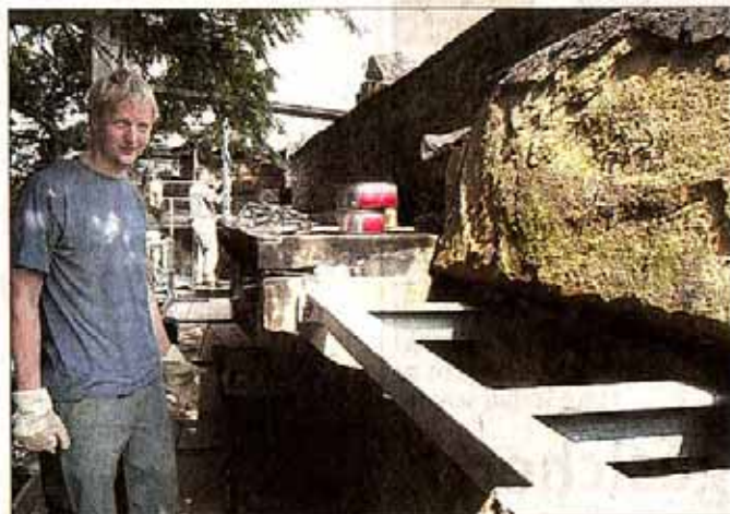
Steinmetz Bastian Falterbaum befestigt die Wehrgangplatten auf der neuen Unterkonstruktion.
