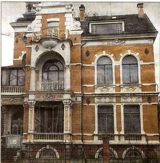
Noch sieht es der Betrachter nicht. Die Sanierungsarbeiten in der Villa Bettermann haben bereits begonnen. Foto: Bremshey
