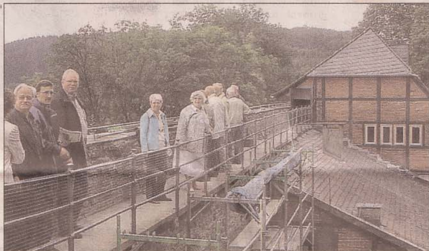
Restlos begeistert zeigten sich die Gäste vom sanierten Wehrgang. Foto: Katja Hofbauer
