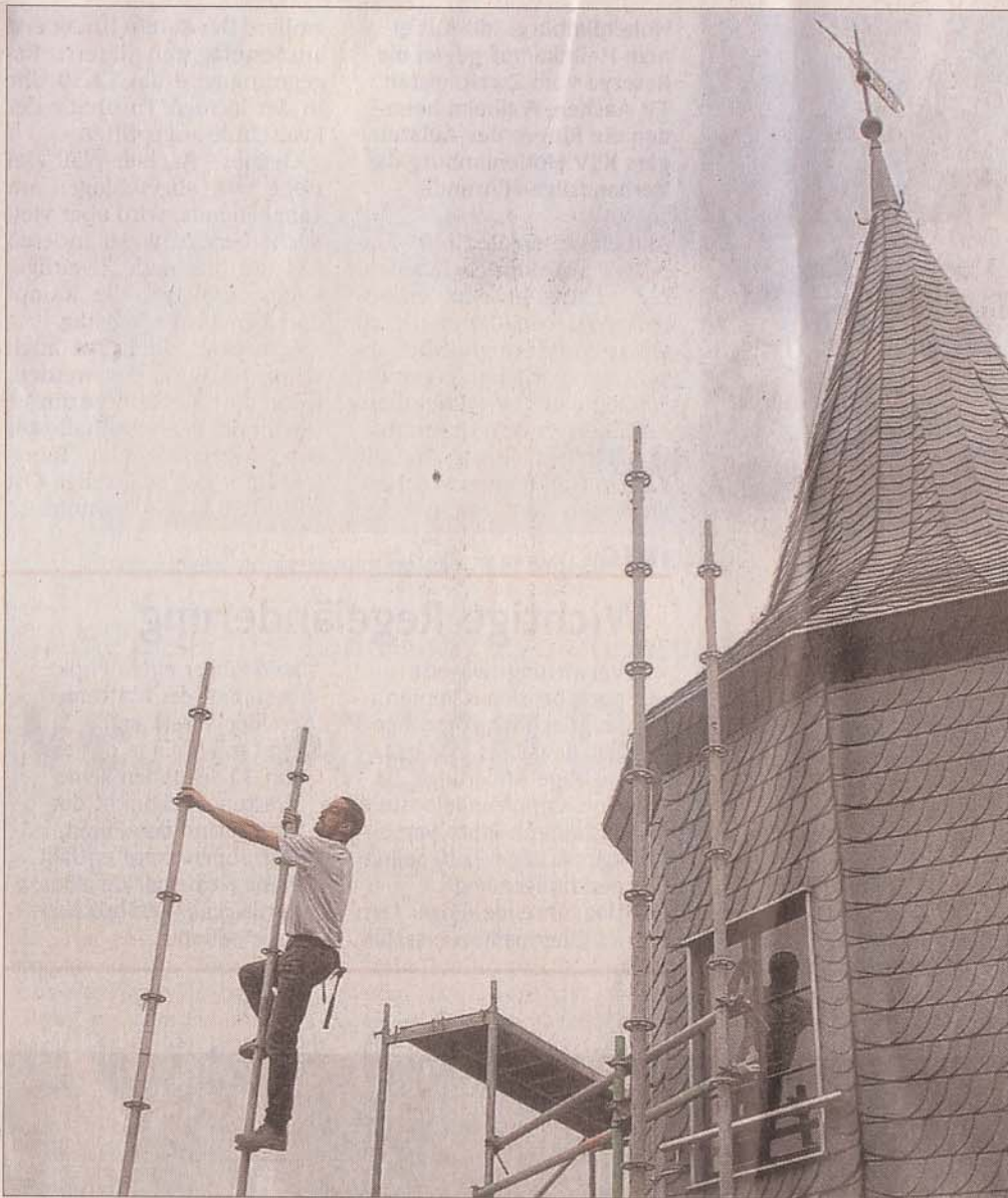
Ein Job in luftiger Höhe: Seit gestern ist Dirk Möller damit beschäftigt, das Gerüst am frisch renovierten Nordturm des Hohenlimburger Schlosses abzubauen. (WR-Bild: Ritter)
