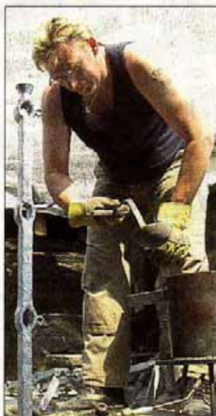
Bleigießen wie in alter Zeit: Schlosser Christian Heinemann arbeitet am historischen Geländer. WR-Bild: Reitmajer
