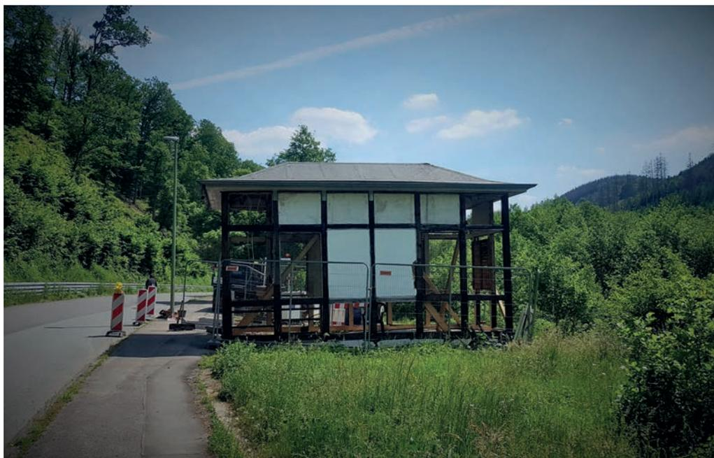
**Das historische Pumpenhaus am Koenig-See wird rückgebaut und saniert. Mitte Mai 2021 hatten Hohenlimburger Handwerker begonnen, die Holzfenster auszubauen, die Gefache zu entkernen und marode Holzbalken auszutauschen. Zudem hat der Energieversorger Mark-E einen Trafo aufgestellt und Kabel verlegt, damit das Pumpenhäuschen nach der Sanierung mit Strom versorgt wird.**
