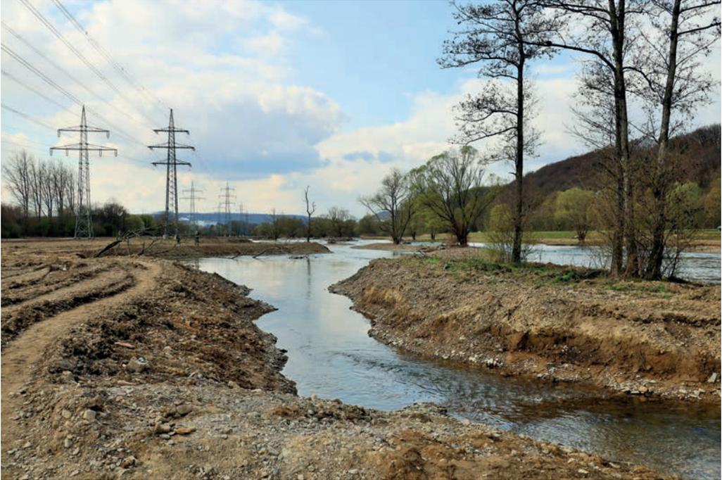
**Renaturierung der Lenne. Der erste von drei Bauabschnitten im unteren Lennetal wird fertiggestellt. Die Maßnahme verfolgt das Ziel, dem Gewässer mehr Freiraum zur natürlichen Entwicklung zu geben. Vorgesehen ist zudem, dass der bislang gepflasterte Fuß- und Radweg eine Asphaltdecke bekommen soll.**
