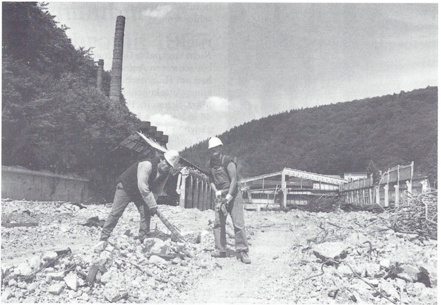
Das Werk 2 der ehemaligen Krupp-Betriebe in der Obernahrmer steht nicht mehr - die Halle wurde dem Erdboden gleichgemacht. Foto: Archiv Westfalenpost
