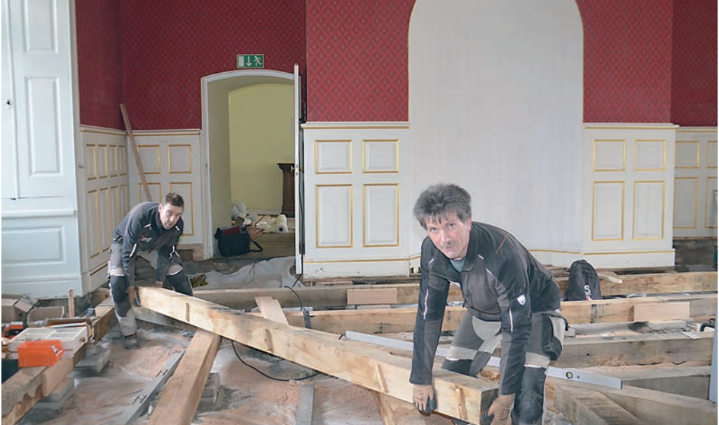
Die Tischler Stefan Hufnagel und Hubert Gramse verlegen neue Holzbalken im Roten Salon. Foto: WESTFALENPOST, Volker Brefshey, 12. Februar 2016
