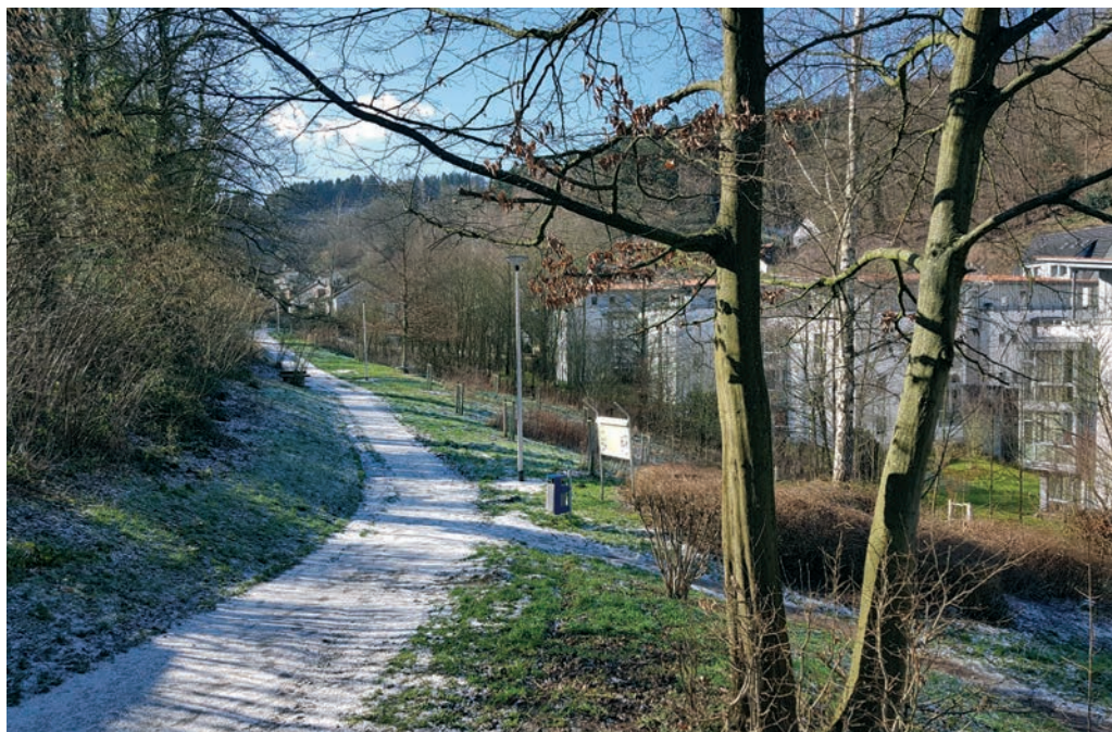
Der Fußweg zwischen Neuer Schloßweg und Wesselbachstraße ist beleuchtet. Die installierten 8 Standmasten haben 3 Helligkeitsstufen. Auf dem Foto zudem sichtbar: Ein Teil der gepflanzten Obstbäume. Foto: Peter Mager, 13. Februar 2018
