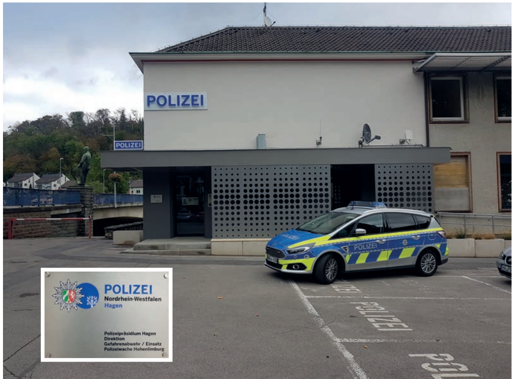
Ansicht der Polizeiwache Hohenlimburg am Rathausvorplatz nach der Sanierung (mit eingeklinkter Nahaufnahme des Schilds an der Wache) Fotos (2): Peter Mager, 25. September 2020
