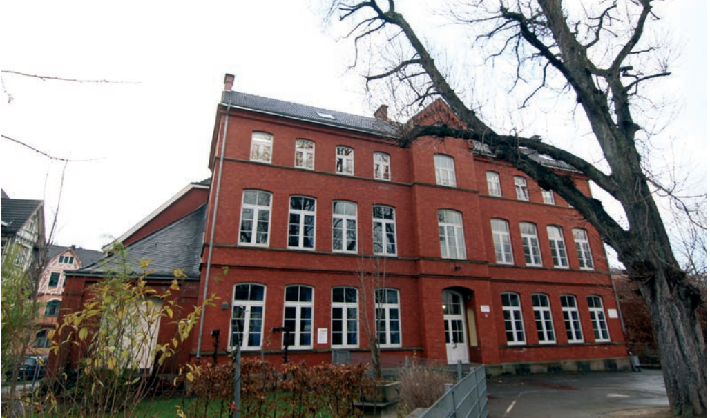
Nach annähernd 120 Jahren verliert das Gebäude der alten Oeger Schule seine Funktion. Die Fassade des Hauses an der Oeger Straße 64 steht seit 1993 unter Denkmalschutz.
