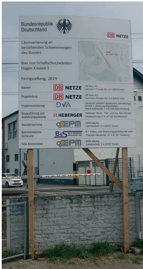
DB NETZE informiert mit Baustellenschildern, wie hier an der Färberstraße, zu den vorgesehenen Lärmschutzmaßnahmen.
