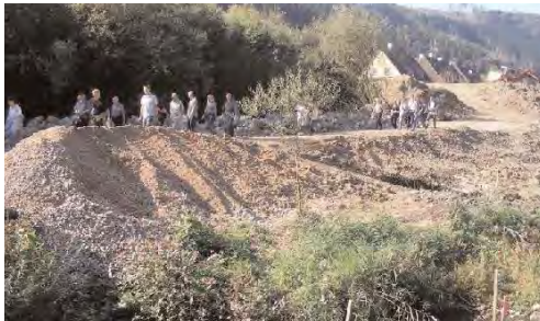
Bürger aus der Nahmer und dem Wessalbachtal verschaffen sich einen Eindruck vom Baufortschritt am Koenigsee
