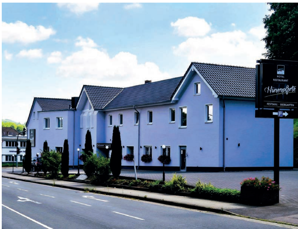
Hotel-Restaurant Hünenpforte in Blickrichtung Hohenlimburger Straße / Sundernstraße. Das neu geschaffene Ensemble integriert Alt- und Neubau mit Hotelkomplex im Obergeschoss.
