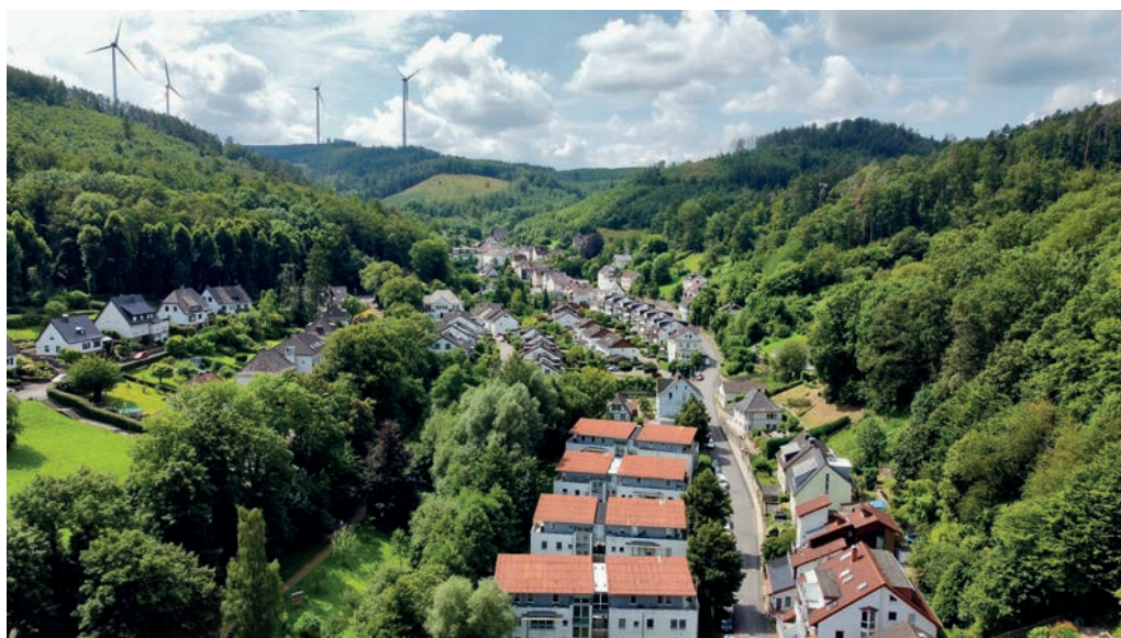
Windenergieanlagen verändern das städtebauliche Bild. Zu sehen sind vier Anlagen und das Wesselbachtal im Vordergrund. Foto: Michael Schneider, 18. Juli 2024
