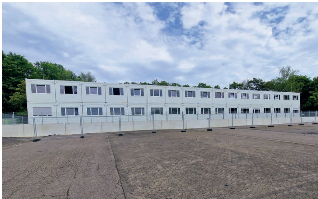
Das Container-Dorf wird als Übergangslösung für Geflüchtete und Zugezogene am Kirchberg errichtet. Foto: Peter Mager, 14. August 2024
