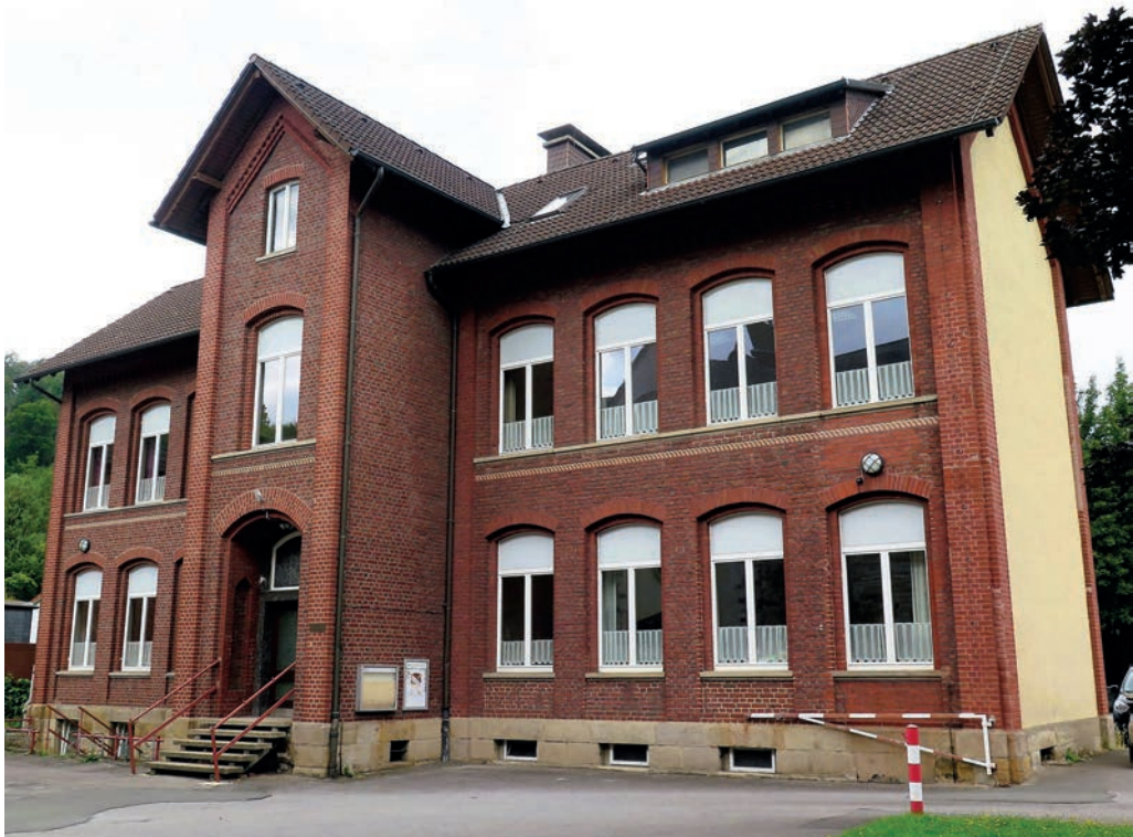
Das Backsteinhaus Alte Weinhofschule wird abgerissen. Das zuletzt als Gemeindehaus dienende Gebäude der katholischen Kirchengemeinde St. Bonifatius wurde bis in das Jahr 1970 als Schulhaus genutzt. Die Schule wurde danach in das Gebäude der Wesselbachschule verlagert (Katholische Grundschule Wesselbach). Entstehen wird am alten Platz im Weinhof der Neubau eines Gemeindezentrums. Foto: Winfried Turner, 21. August 2021
