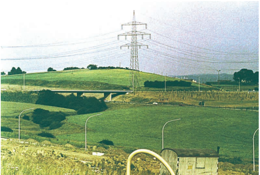
Blick vom Sonnenwinkel um 1970 auf das Gelände des geplanten Kirchenbergstadions mit der im Bau befindlichen Berliner Allee im Vordergrund und der Querspange mit Brücke über die heutige A 46 in der Bildmitte
