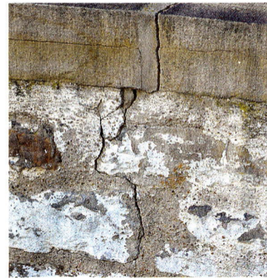
„Die Risse sind kein Problem“, so Georg Verfuß, der Hausbesitzer. FOTO: BREMSHEY
