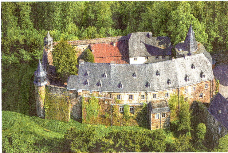
Schloss Hohenlimburg ist eine der wenigen noch weitgehend in der ursprünglichen Baugestalt erhaltenen Höhenburgen in Westfalen.
