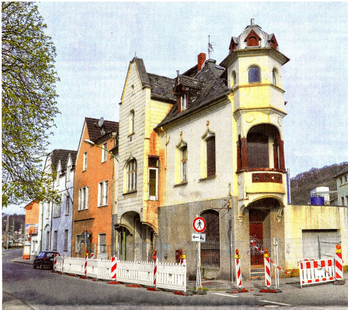
Die Stadt Hagen erwarb gestern Morgen das Oeger Schlösschen für 6100 Euro. Jetzt soll das Gebäude so schnell wie möglich abgerissen werden, damit Fußgänger und Autofahrer nicht mehr gefährdet werden.
