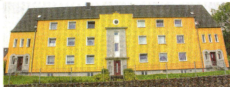
Ein Zeichen für eine mehr als gelungene Sanierung – das ehemalige Haus Georg-Scheer-Straße 47, erbaut im Jahr 1929, heute Heidestraße 59.
