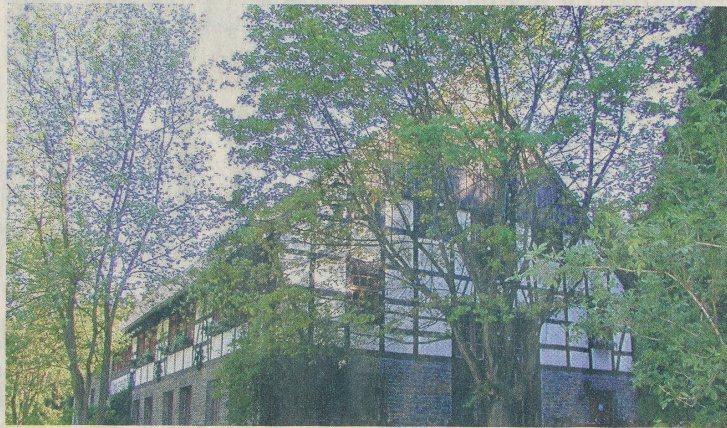
Neue Heimat: Das Haus Letmathe wird ab 2021 für die Ausstellungsstücke des Deutschen Kaltwalzmuseums umgebaut.
