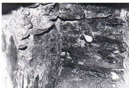
Nahfoto des Eck-Befundes im alten Rauchhaus
