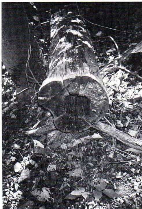
Schloßnahes Stück der Holzröhrenleitung am Schloß-Südhang
