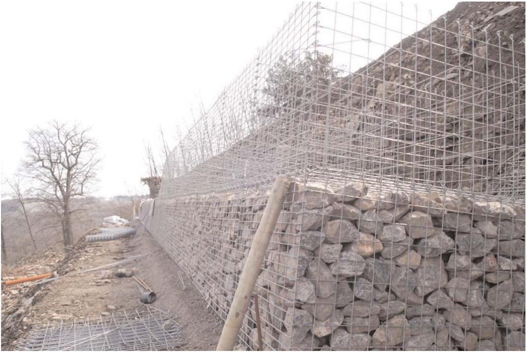
Als nördliche Begrenzung des Schloßgartens entsteht im April 2006 die Gabionenmauer, gefüllt mit Kalksteinen aus dem Steinbruch zwischen Oege und Steltenberg.
