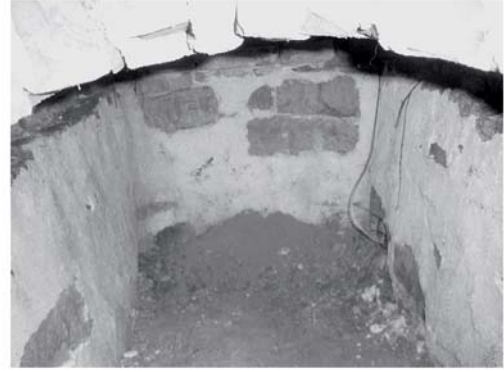
Wandverputz und Segmentbogen der zweiten Gruft Foto: H. Klötzer
