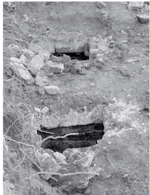
Einstiegslöcher für die zwei intakten Gräften
