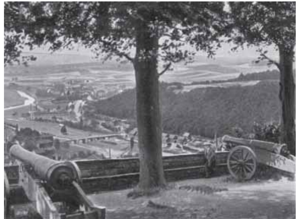
Blick von der Terrasse vor Schloß Hohenlimburg mit den Schloßkanonen auf Hohenlimburg um 1900. Von der Bogenbrücke über die Lenne geht der Blick rechts der Brücke auf die Häuserreihe am Mühlenberg und oberhalb der Brücke auf das Mühlendorf - aus dem in den sechziger Jahren des vorigen Jahrhunderts der Lennepark entstand - mit dem langgestreckten Gebäude der Tuchfabrik H.D. Nettmann & Sohn und auf das Dorf Elsey im Hintergrund. Am rechten Bildrand sieht der Betrachter auf der noch unbebauten Hochfläche auf der Heide Äcker und Wiesen. Foto: Archiv Verein für Orts- und Heimatkunde Hohenlimburg e.V.
