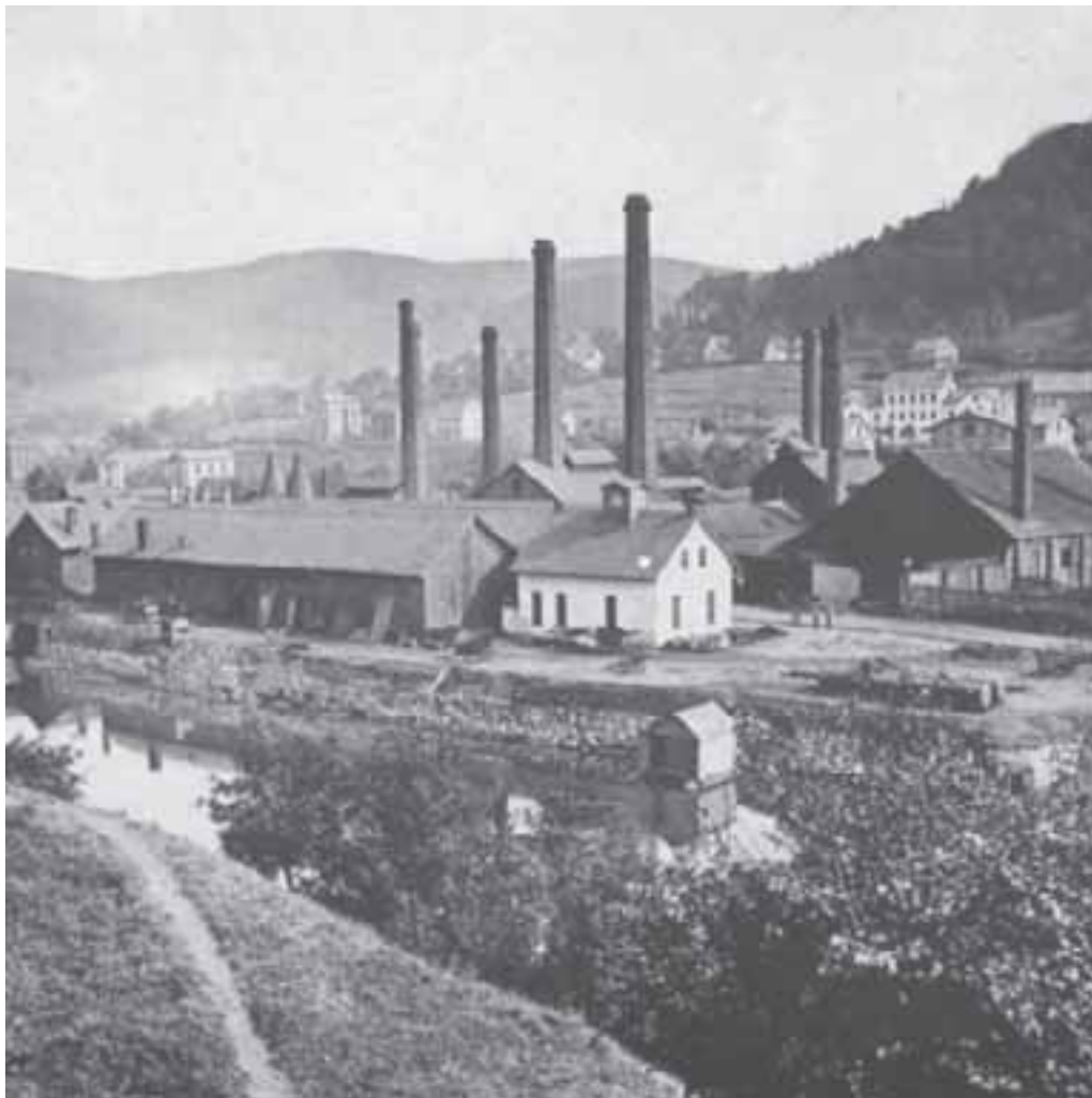
Limburger Fabrik- und Hüttenverein (heute Hoesch Hohenlimburg GmbH – ThyssenKrupp-Gruppe) im Hohenlimburger Langenkamp um 1882, wo sich heute das Parkhaus mit Busbahnhof (rechts) und das Hoesch-Verwaltungsgebäude (bzw. „Stadt Hagen - Hagener Betrieb für Informationstechnologie - Systemhaus für Hagen und Ennepe-Ruhr“) erstrecken. Am rechten Bildrand ragt hinter der Fabrikhalle das Dach des Bahnhofsgebäudes von 1882 hervor. Über der Fabrikhalle in der Bildmitte erheben sich die ersten Häuser an der Kaiserstraße. Etwa in Höhe des linken Bildrands führt heute die 1971 gebaute Brücke über die Lenne.
