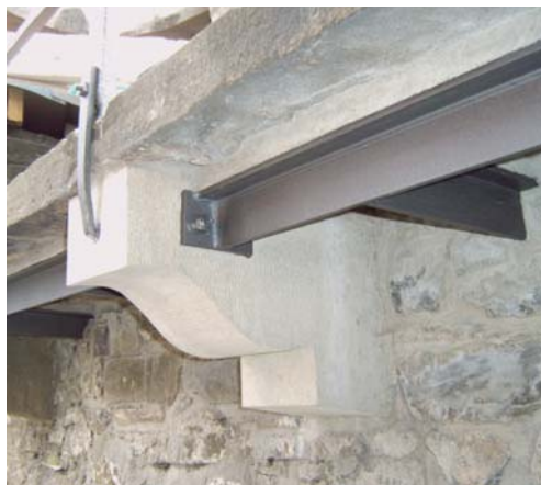
Eine der Konsolen aus Ruhrsandstein im östlichen Teil des Wehrgangs mußte neu gefertigt werden. Die Stahlträger unter den Steinplatten sind mit der Wehrmauer und durch Dübel mit den Konsolen verbunden.
