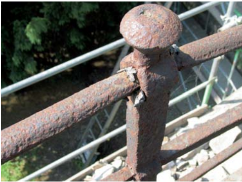
Detailaufnahme des historischen Wehrgang-Geländers aus Puddeleisen vor der Sanierung. Foto: Jochen Hüning, 17. Juni 2006
