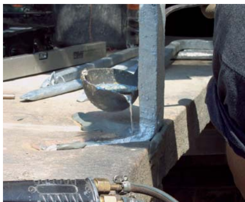
Aus einer Kelle wird flüssiges Blei an den Fuß der feuerverzinkten Geländerhalterung gegossen. Foto: Michael Rabe, 6. Juni 2006
