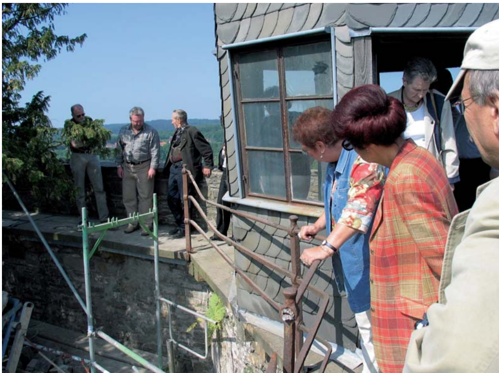
Vorstand, Beirat und engagierte Mitglieder des Heimatvereins besichtigen die Baustelle Wehrgang. Im Hintergrund, Bildmitte: Architekt Michael Rabe. Foto: Jochen Hüning, 17. Juni 2006
