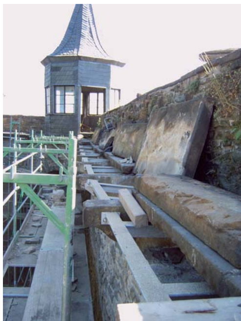
Die Sanierung der Trittfläche machte es erforderlich, die Steinplatten aufzunehmen und neu zu verlegen. Unter den hochgeklappten Platten sind die zur zusätzlichen Absicherung eingefügten Stahlträger erkennbar (südlicher Teil des Wehrgangs).
